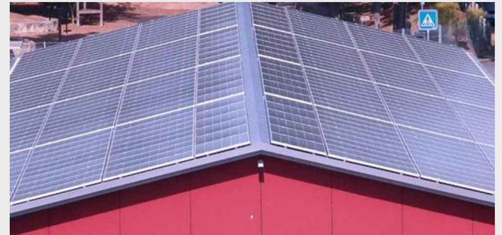
Abb. 10: Dachfläche Haupt-, und Lagergebäude Fellbach
