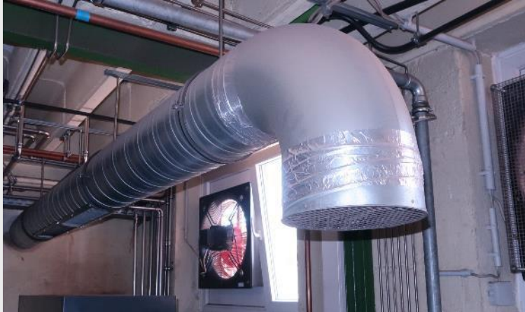
Abb. 11 : Ansaugstutzen für Warmluft im Kompressorraum
