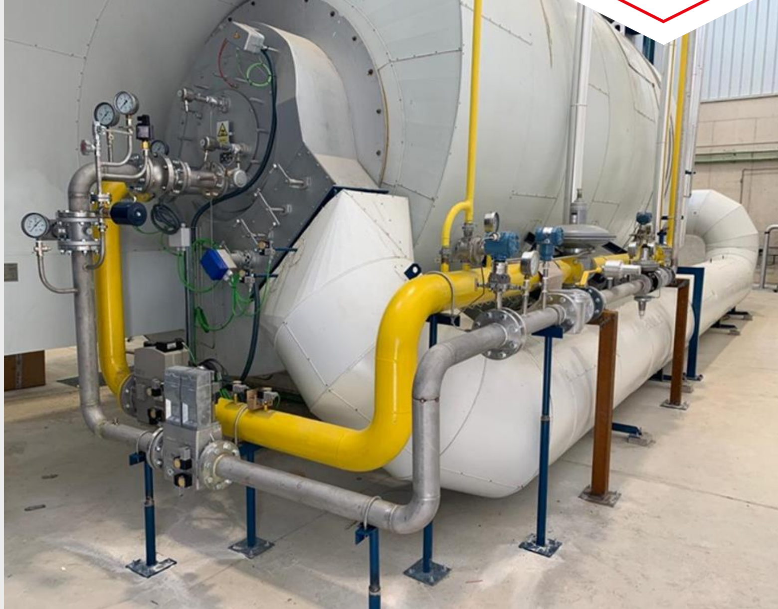
Abb. 6: RAY-EGELHOF Prozesswärme aus Wasserstoff mit niedrigsten Stickoxidemissionen (Standort: Cáteda, Spanien)
