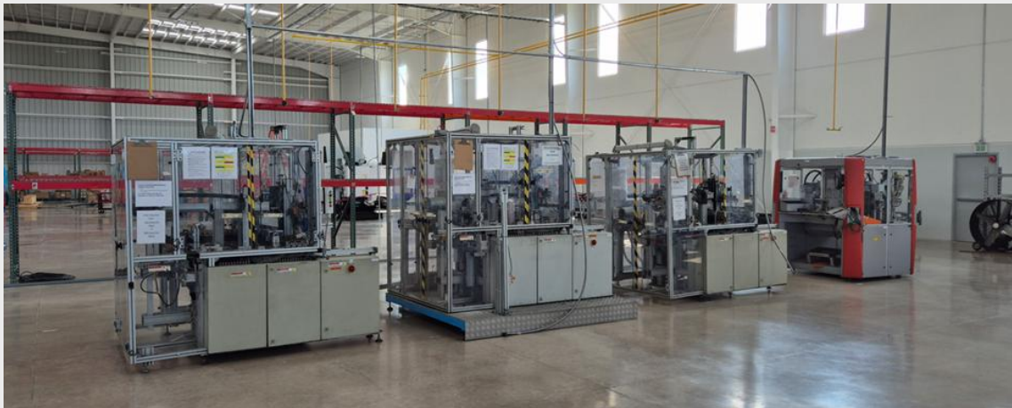
Abb.3: Die Arbeitsplätze für das neue Werk im mexikanischen Silao sind Mitte 2025 am Standort eingetroffen.
