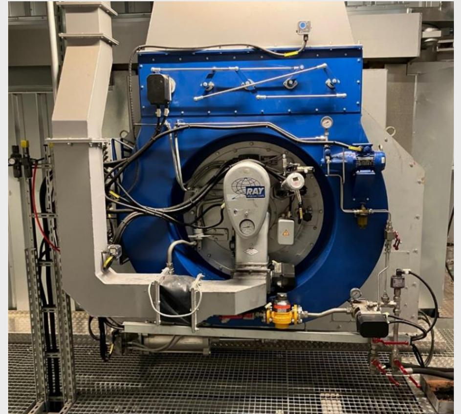
Abb.12: RAY Egelhof-Brenner im Kraftwerk (RAY-Rotationsbrenner BGE 25000)
