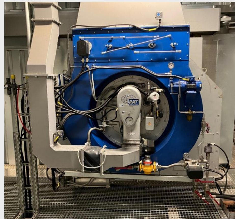
图12: 电站中的 RAY Egelhof 燃烧器 (RAY 旋转燃烧器 BGE 25000)
